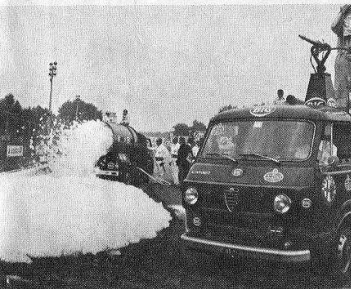
A Monza vengono usati gli autocarri speciali Alfa Romeo A. 12 che hanno un enorme carico di materiale antincendio, ma poca velocità d'intervento. Sotto: uno dei Maserati della CEA-Estintori in servizio all'autodromo di Imola. Può spegnere 500 litri di carburante e coprire di schiuma cinque vetture incendiate. Ha una velocità di 220 kmh
