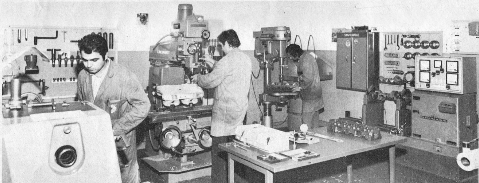
Ecco un altro reparto delle Officine di precisione Morand: a destra il laboratorio meccanico che per mezzo delle sue attrezzature ultra moderne può fabbricare in proprio le parti speciali. A sinistra la fabbricazione, ex-novo, di un albero motore per propulsore da gara
