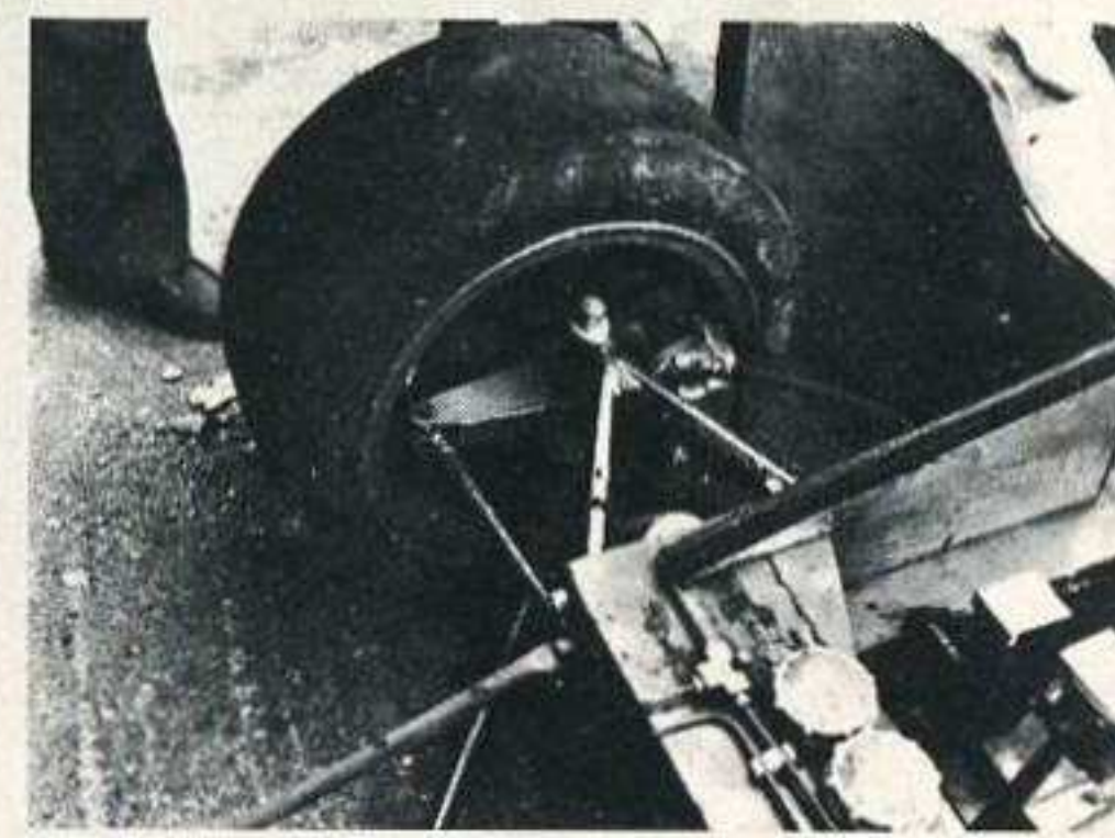
A sinistra, la carrozzeria della Dallara Sport è in un sol pezzo, e si solleva come in un micromodello da piste elettriche. Sopra, la sospensione anteriore destra. Le ruote davanti sono completamente carenate. Sotto, il motore e le sospensioni posteriori
