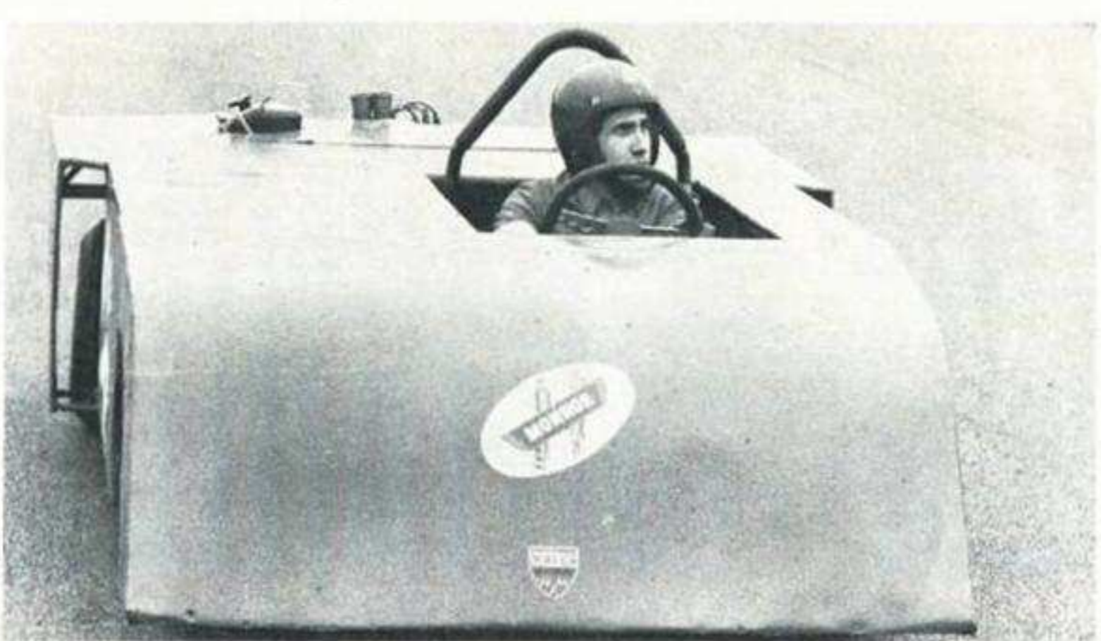
Una vista posteriore della CRM-DKW condotta in corsa da Franco Negro. Il radiatore acqua è posteriore, dietro ai grossi scarichi, mentre il cambio è quello della Fiat 500. Presto si monterà un 1000
