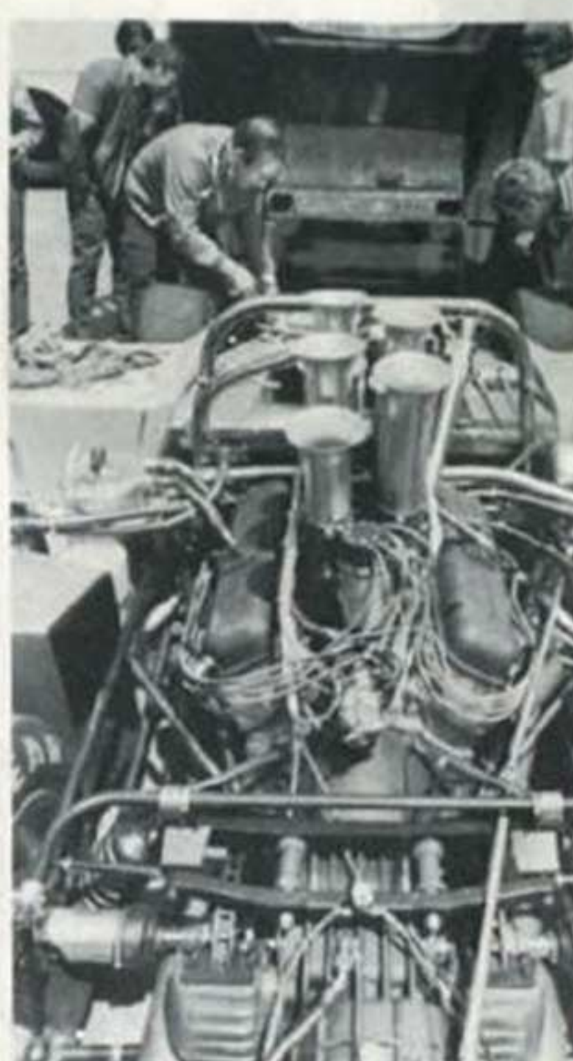
A sinistra, la robustissima scocca in lega leggera delle nuove McLaren M20. Sopra, l'8 V Chevrolet da 8100 della stessa macchina (foto DPPI)
