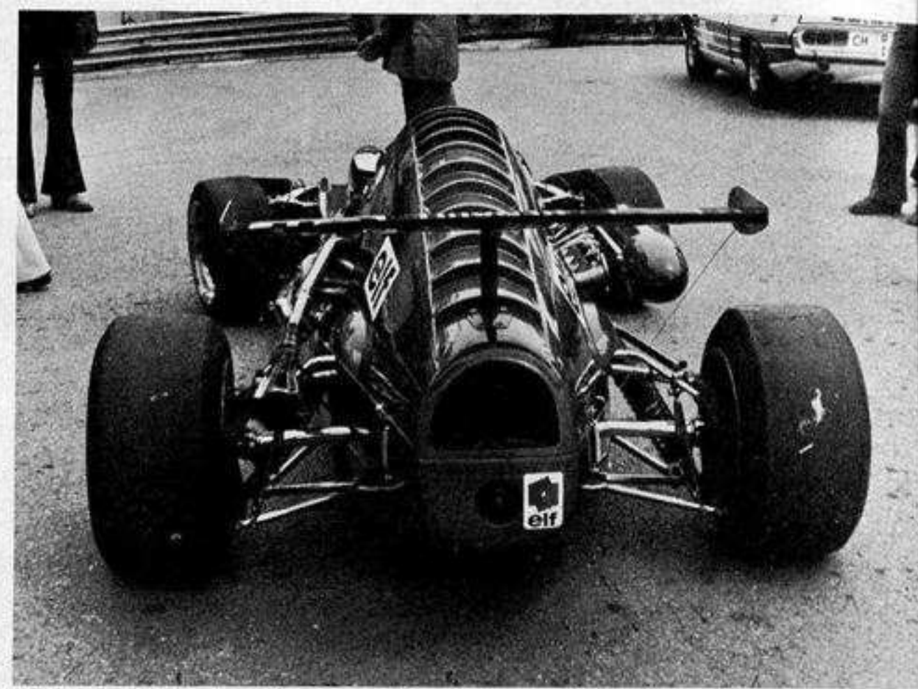
L'Alpine A 364 di Depailler vista dal dietro mostra nella sua completezza l'accurata carenatura che avvolge il motore e cambio. L'alettone posteriore, sorretto da un solo sostegno, è tenuto fermo alle estremità da due tiranti in nylon
