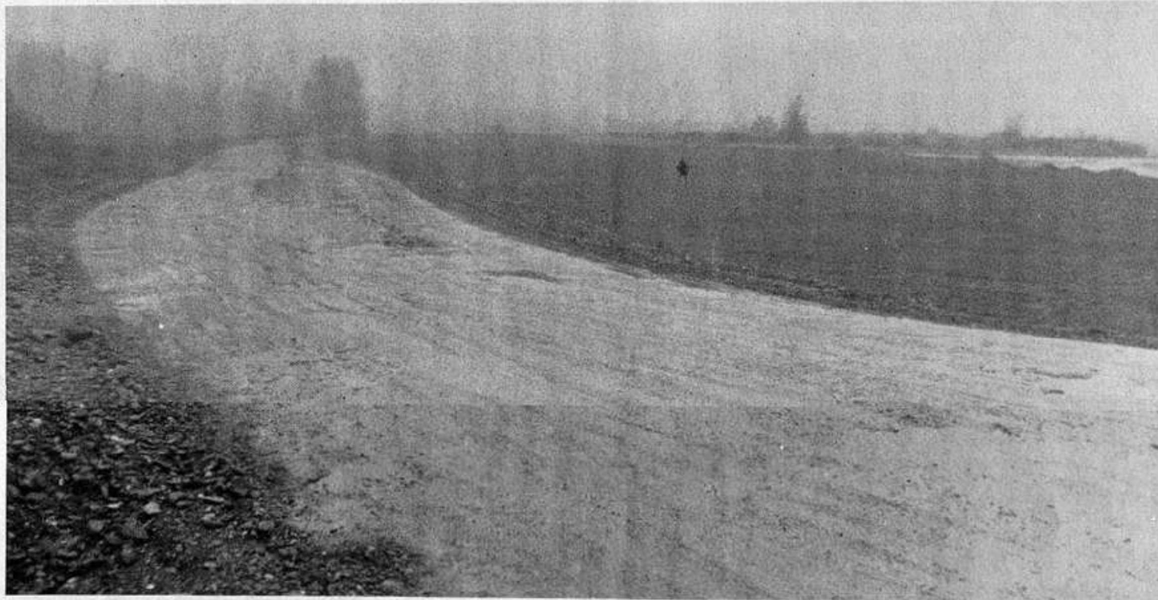
Sopra, già sbancato e pronto per l'asfalto il nuovo tratto di pista. In fondo, il tracciato preesistente. Verranno previsti guardrail all'esterno. Sotto, il «tornantino» è stato addolcito in questo modo
