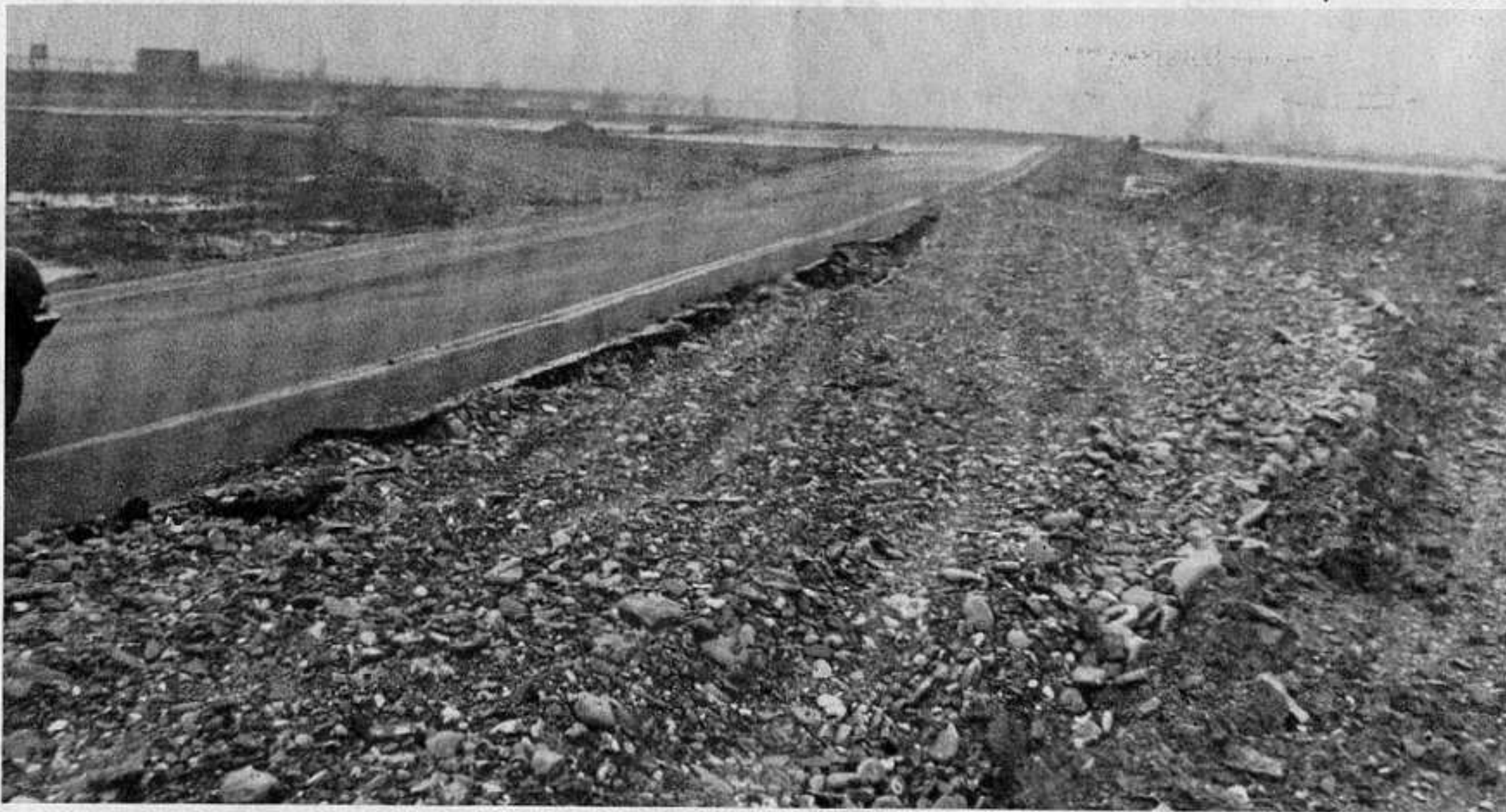
Sopra, già sbancato e pronto per l'asfalto il nuovo tratto di pista. In fondo, il tracciato preesistente. Verranno previsti guardrail all'esterno. Sotto, il «tornantino» è stato addolcito in questo modo
