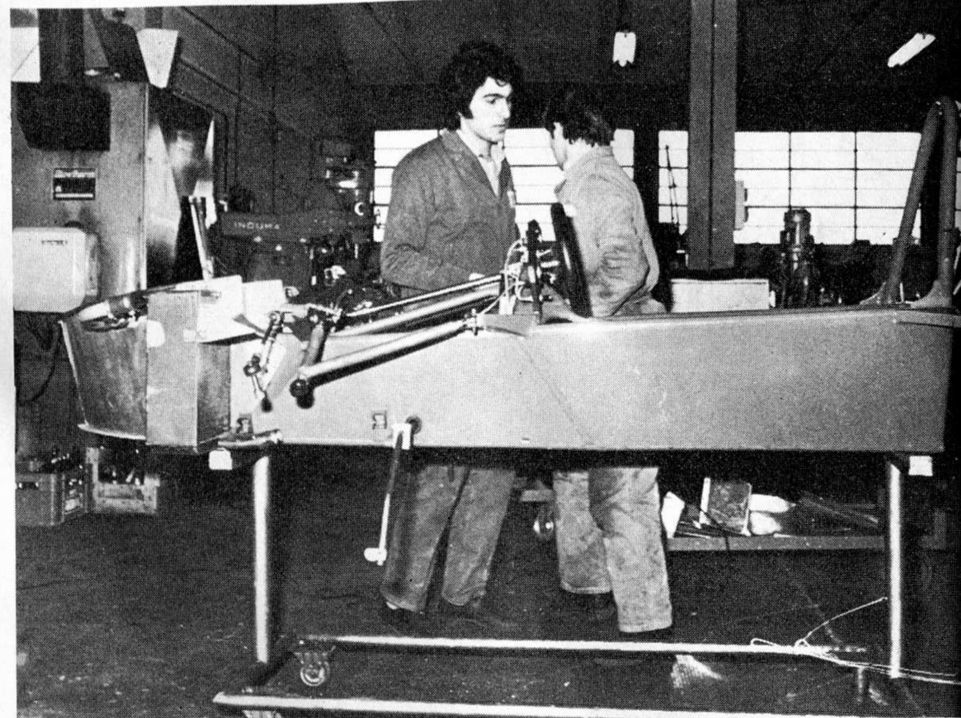
Rimessa a nudo, ecco la scocca delle Tecno Formula 1 in attesa di ricevere i nuovi serbatoi. Dopo la modifica, la F.1 bolognese rientrerà nei 110 centimetri previsti. Nella foto è in evidenza la compattezza del telaio, a traliccio, che termina alle spalle del pilota col motore portante
